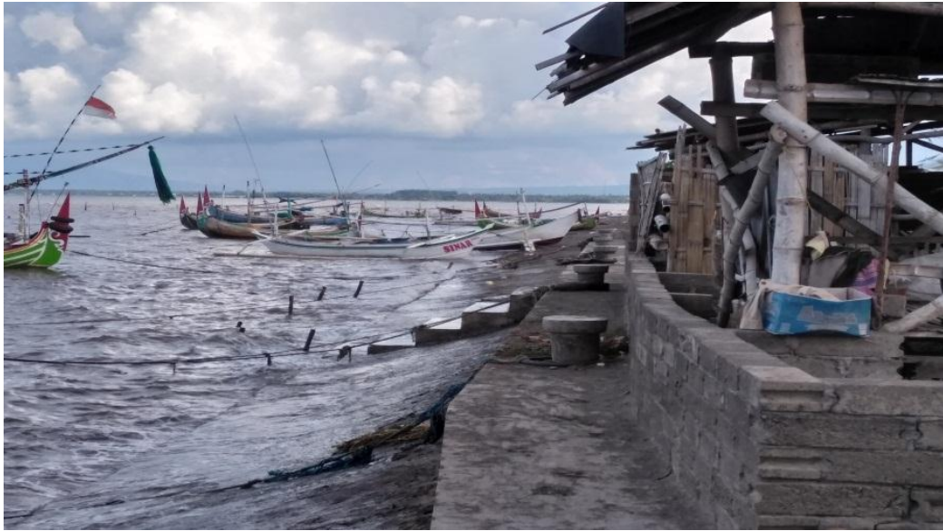
Gambar 1. Bangunan Tambat Perahu (Doc. Pribadi, 2023)
