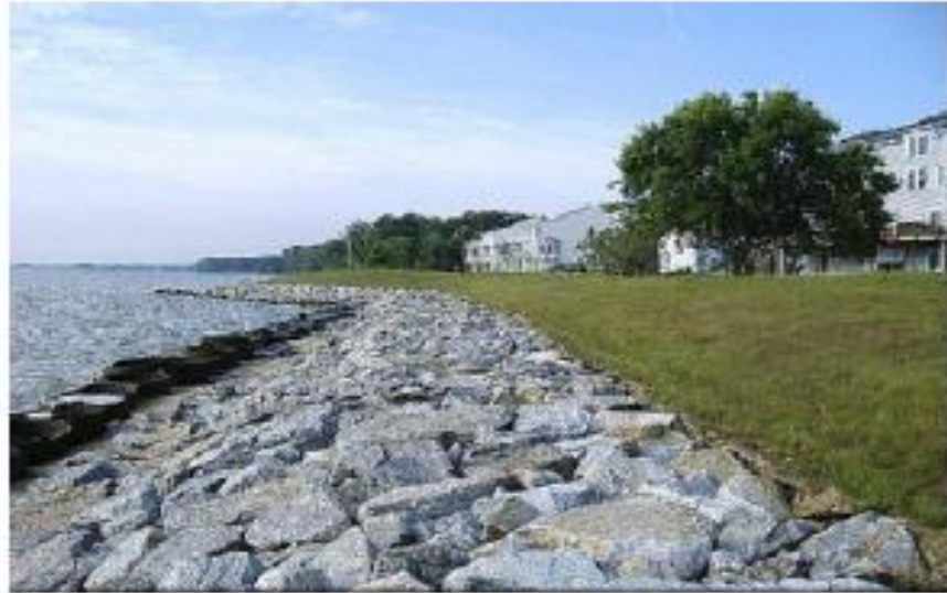
Gambar 2.4. Bangunan Revetment (Pratikto et al. , 2017)
